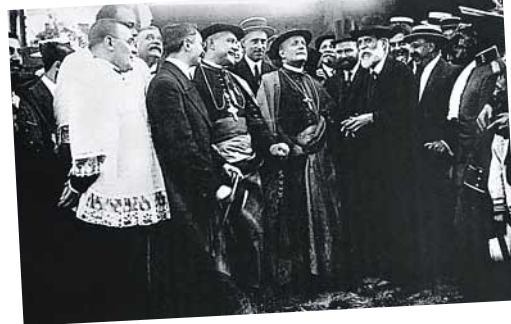
Gaudí presents the construction site of the Sagrada Família.
